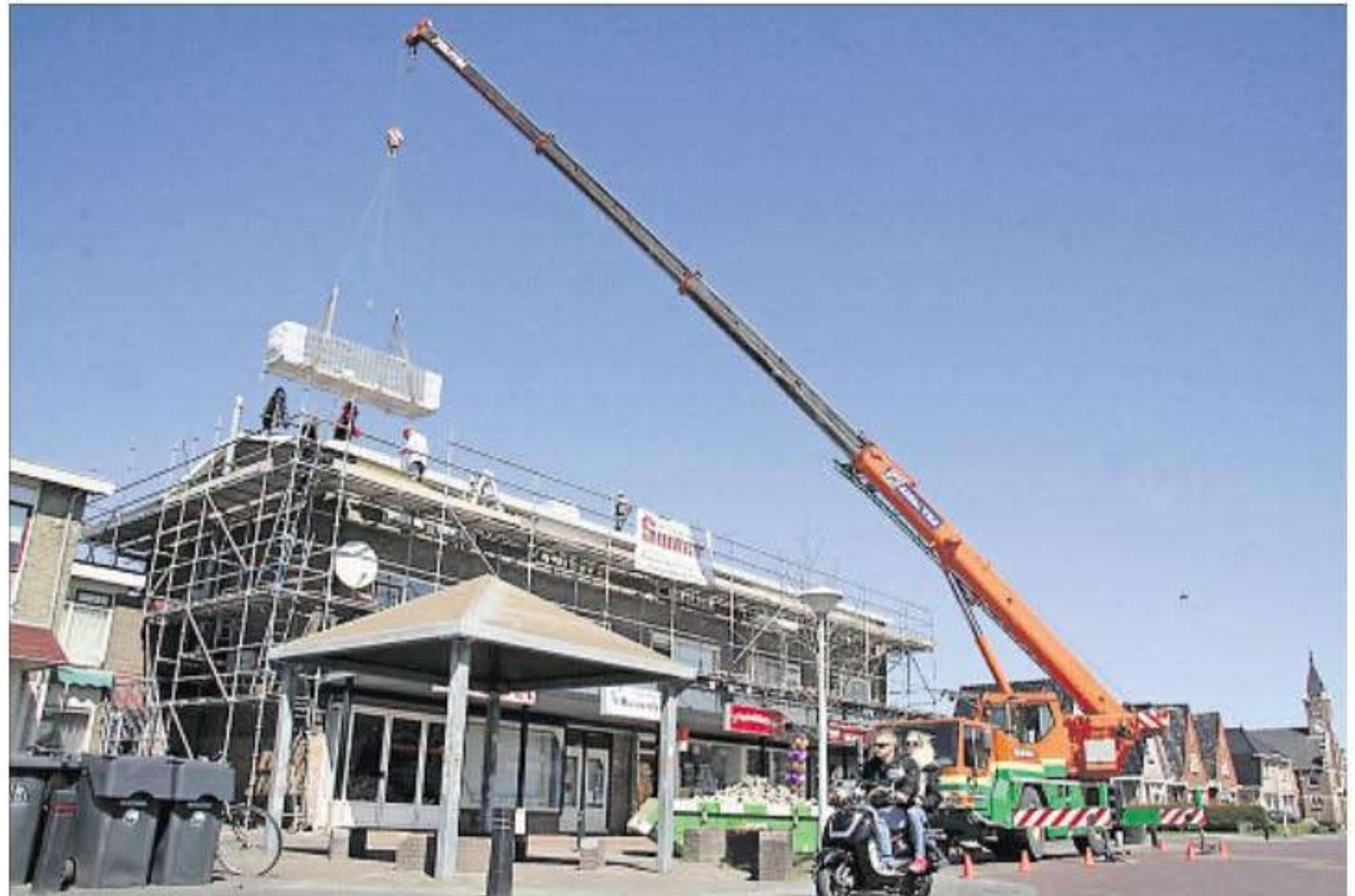
Onder een strakblauwe lucht takelt een kraan dakplaten naar boven.
