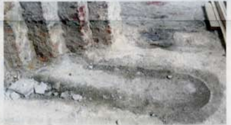
Rechts: het lek in de vloerverwarming waardoor een grote onderhoudsbeurt van de Kruiskerk noodzakelijk werd. De foto boven laat de pilaren zien waarvan het stucwerk was aangetast door het lek.
