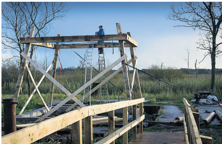
De uitkijktoren in de Jan Durkspolder in wording: het onderstuk is geplaatst.
